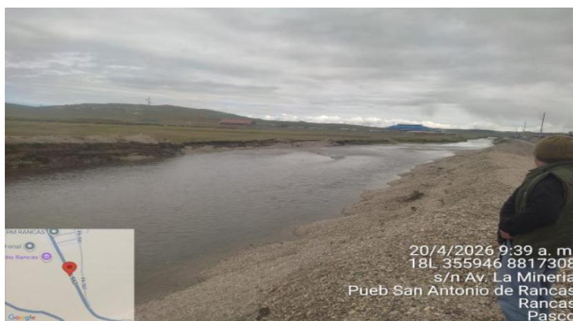
IMAGEN 03: SE OBSERVA LA EROSION EN AMBAS MARGENES DEL TRAMO PARA CONSTRUCCION DE MURO DE CONCRETO
